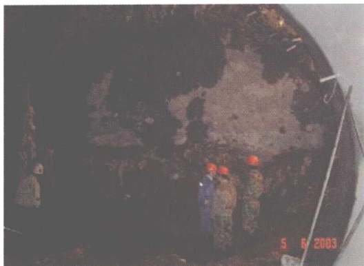
图 1-5 高压动水粉细砂层充填型溶洞注浆堵水后开挖照片
