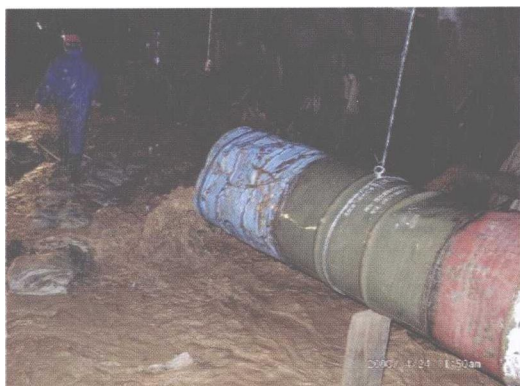
图 1-4 高压动水粉细砂层充填型溶洞突水照片
