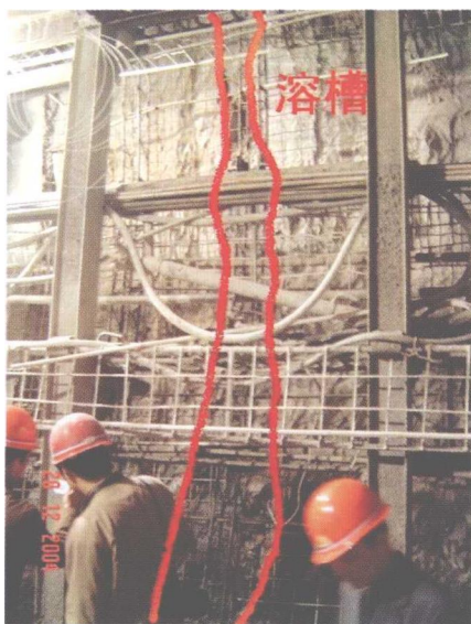
图 1-7 富水溶槽注浆后开挖照片
