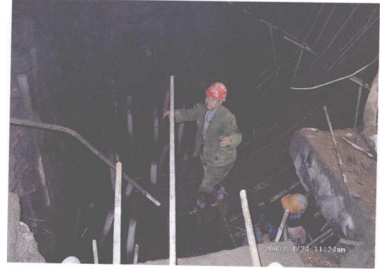
图 1-2 淤泥质充填型溶洞基底注浆前取心照片 图 1-3 淤泥质充填型溶洞基底注浆钢管桩加固照片
