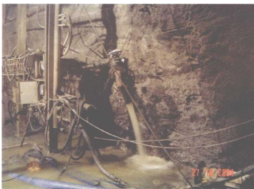
图 1-6 富水溶槽探水孔照片
