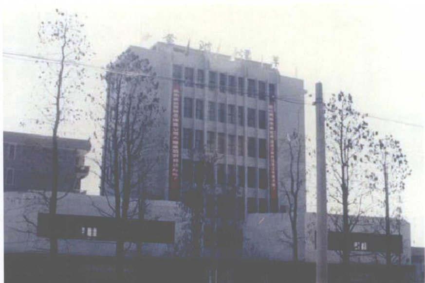
■ 1991年5月1日，黄陂烟草新办公大楼落成。图为办公大楼全景
