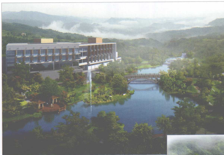
建设中的金山国际医院
