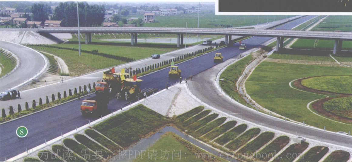
路面施工现场
