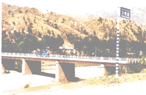
保涞公路涞源走马驿桥
