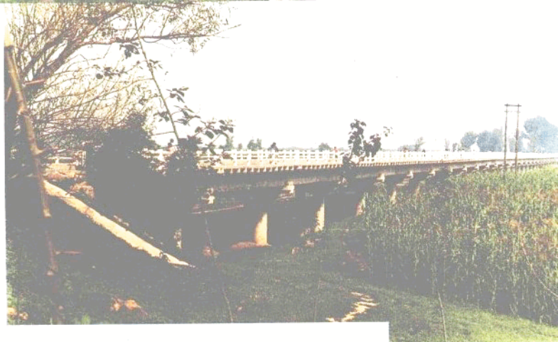
保沧公路高阳莘桥蒲龙河桥
