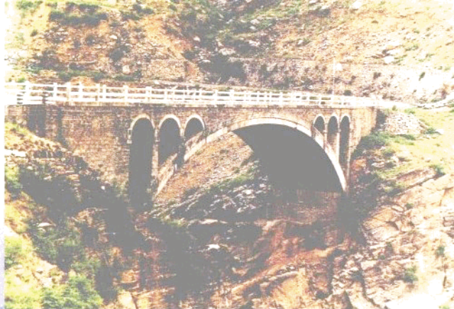
阜繁公路阜平 大窗台桥
