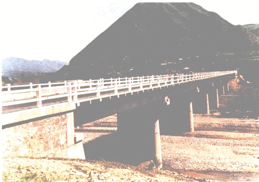
京昆公路涑水马各庄桥
