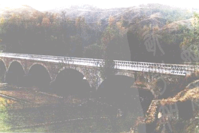
保涞公路唐县倒马关桥
