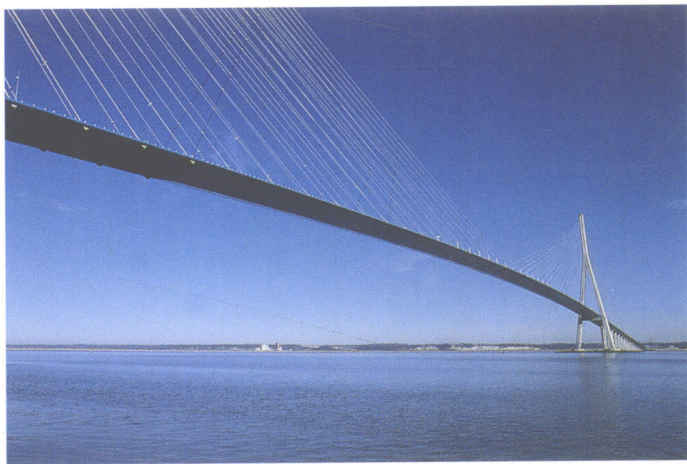
上图：位于法国北部的诺曼底大桥在塞纳河入口处独领风骚
