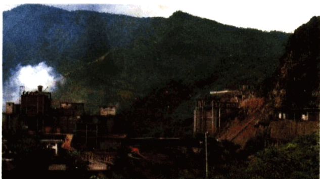
▶图3：蕉岭县矿藏资源丰富，其中石灰石储量有5亿多吨，图为县坑头水泥厂一角
