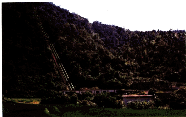
◀图 1：蕉岭县水力资源丰富，可开发量约10万千瓦，现已装机7.8万千瓦。图为县办的多宝水电站。
