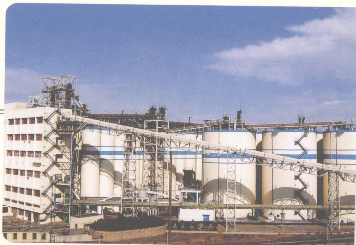
散粮进出口线
