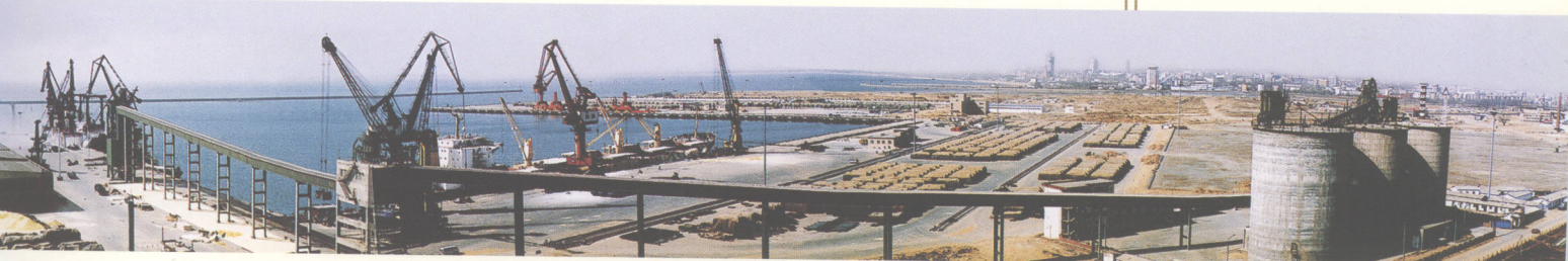
散水泥出口线
