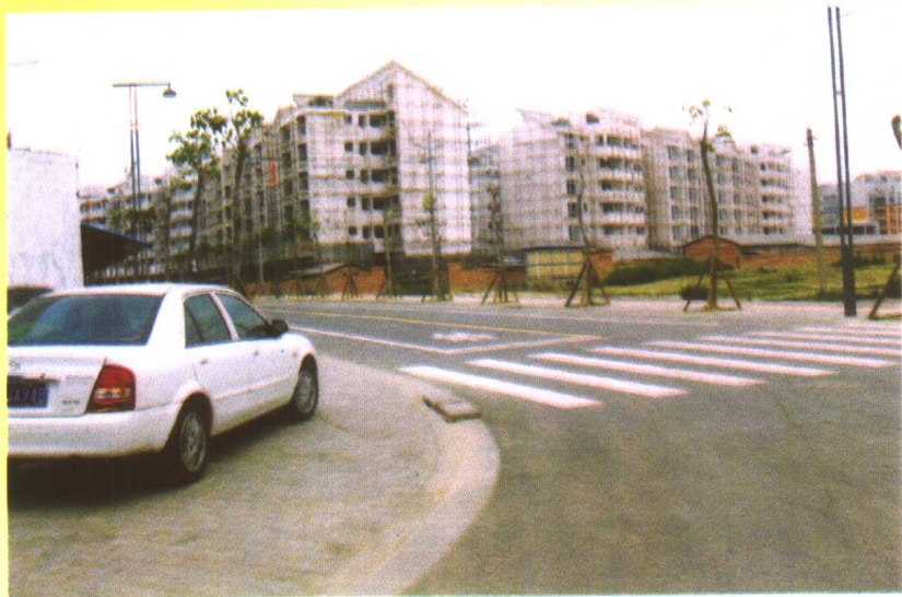
新居工程“康庄小区”扬尘治理新貌
