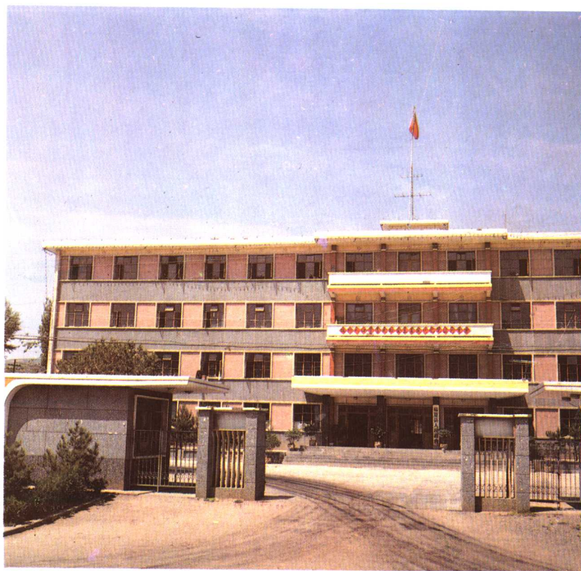
县政府办公大楼
