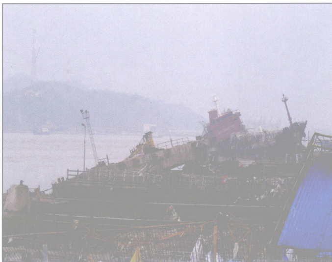
图 8 2004 年 8 月 12 日“云娜”台风浪对浙江椒江口海门码头和船舶造成严重损坏
