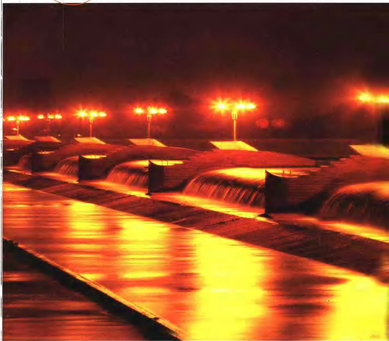
沂河橡胶坝——世界第一大橡胶坝
