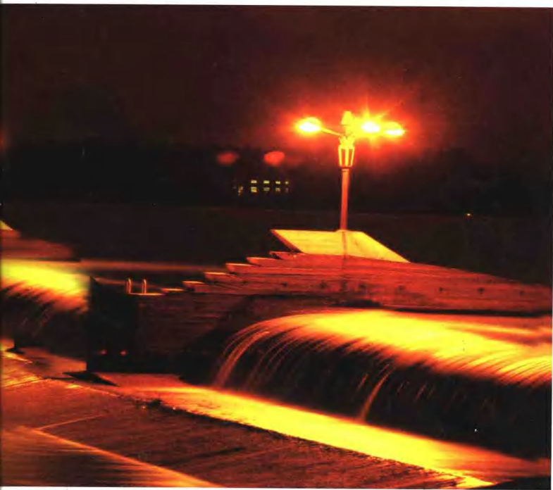
沂·河·橡·胶·坝 Yihe Rubber Dam
