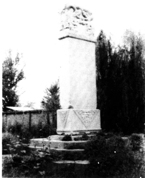
忠兴寺宁佑庙 乾隆题诗碑 (在今忠兴庄变电站内)
