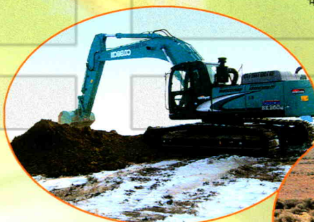
别斯库都克煤矿开工动土“第一铲”
