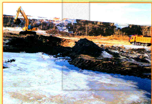
别斯库都克煤矿剥离拉沟场面
