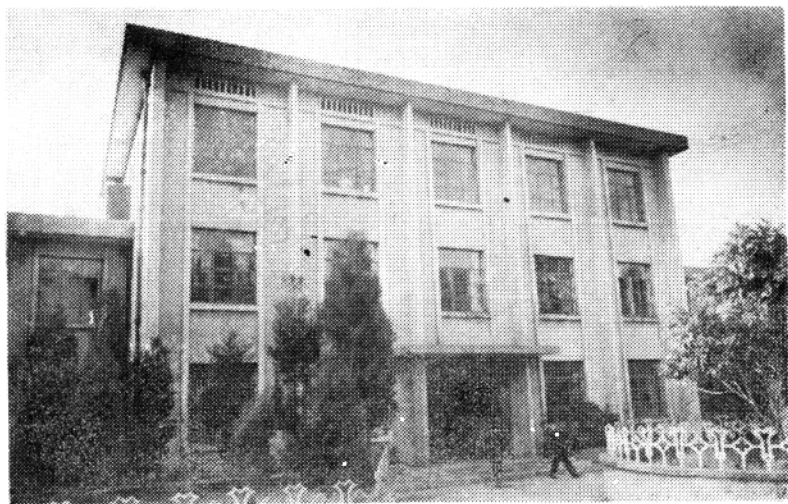
西昌铁路法院、检察院大楼
