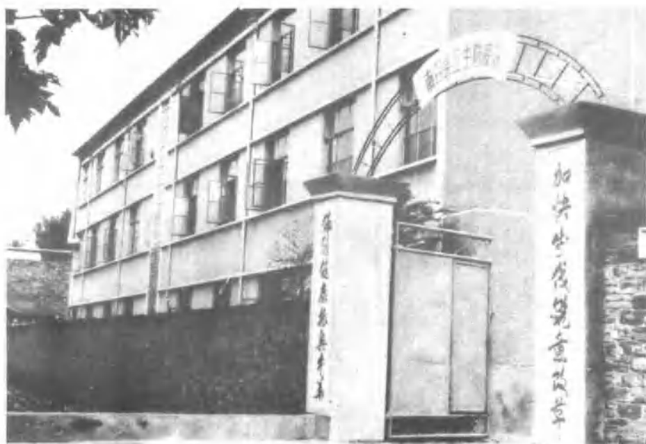
南召县卫生防疫站办公楼
