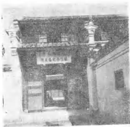
中共浙东区委员会旧址大门口
