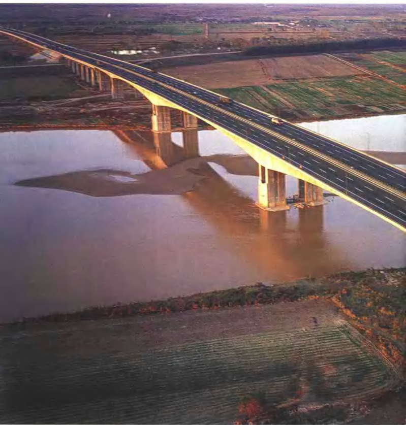
北京 - 福州高速公路济南黄河大桥
