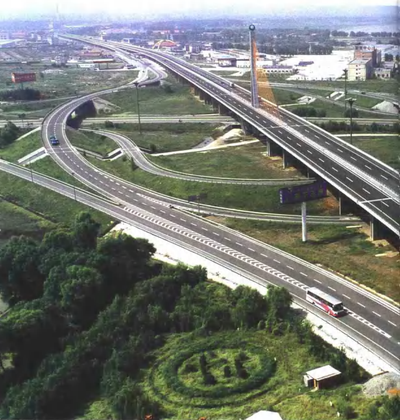
济南—青岛高速公路零点立交桥
