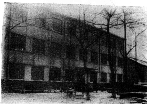
市药品检验所新建的检 验楼 (冉军科 王志刚)
