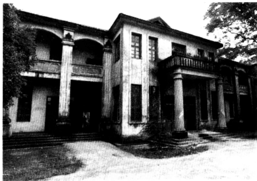
桂林甲山办公大楼
