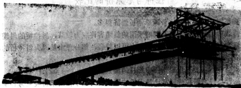
图1：多米尼加共和国利奥希瓜莫桥——采用移动式吊篮就地灌注的分段双悬臂结构
