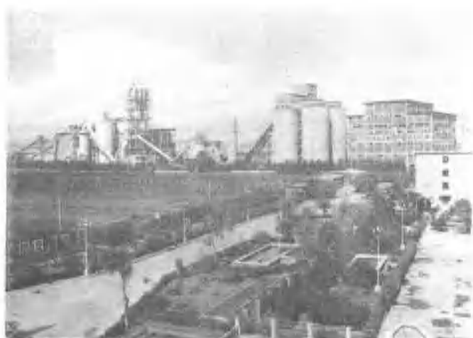
◀ 冀东水泥厂是用日本进口的全套设备建设起来的现代化水泥企业
