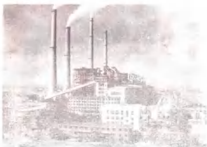
◀ 唐山陡河电厂是用日本进口的全套设备建设起来的大型发电企业
