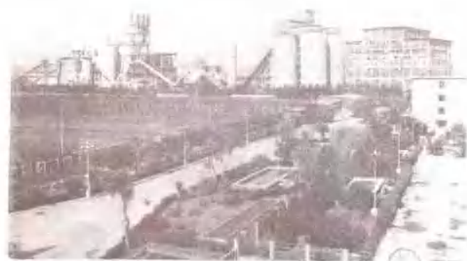
◀ 冀东水泥厂是用日本进口的全套设备建设起来的现代化水泥企业
