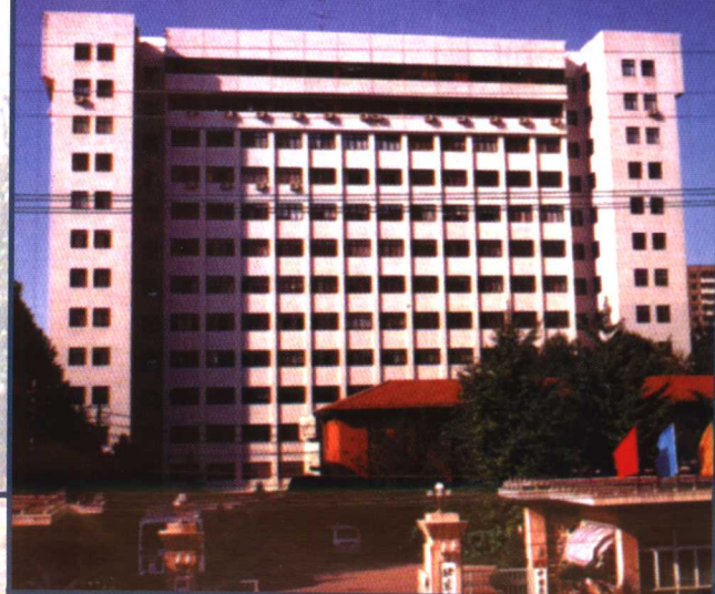
北京商学院综合教学楼
