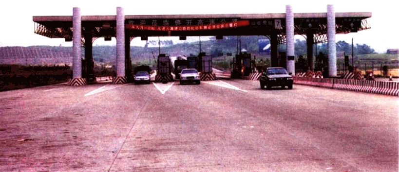
佛开高速公路陈山站
