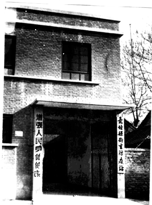
长垣县卫生防疫站办公楼
