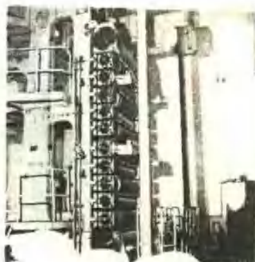
82年安装完毕的十二辊压光机 光机侧面
