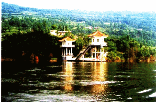
▶ 杨家坝水库灌溉、人饮放水闸。
