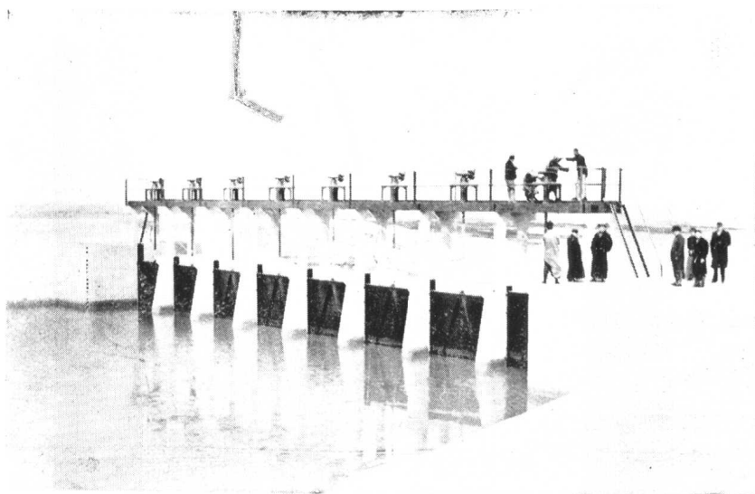
海河放淤金鐘河洩水閘
