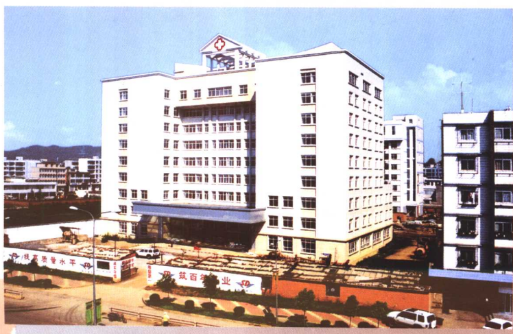
新建的县医院门诊大楼
