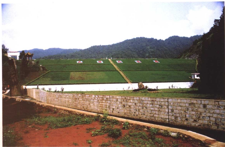
大石头水库大坝
