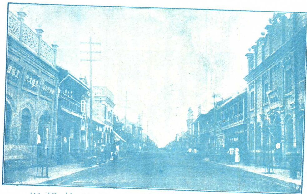
影撮林路道植栽及成完路和共封開
