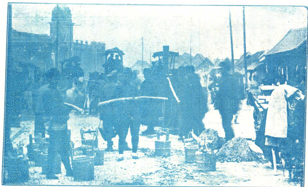
開封中山路緩行道改鋪碎石情形
