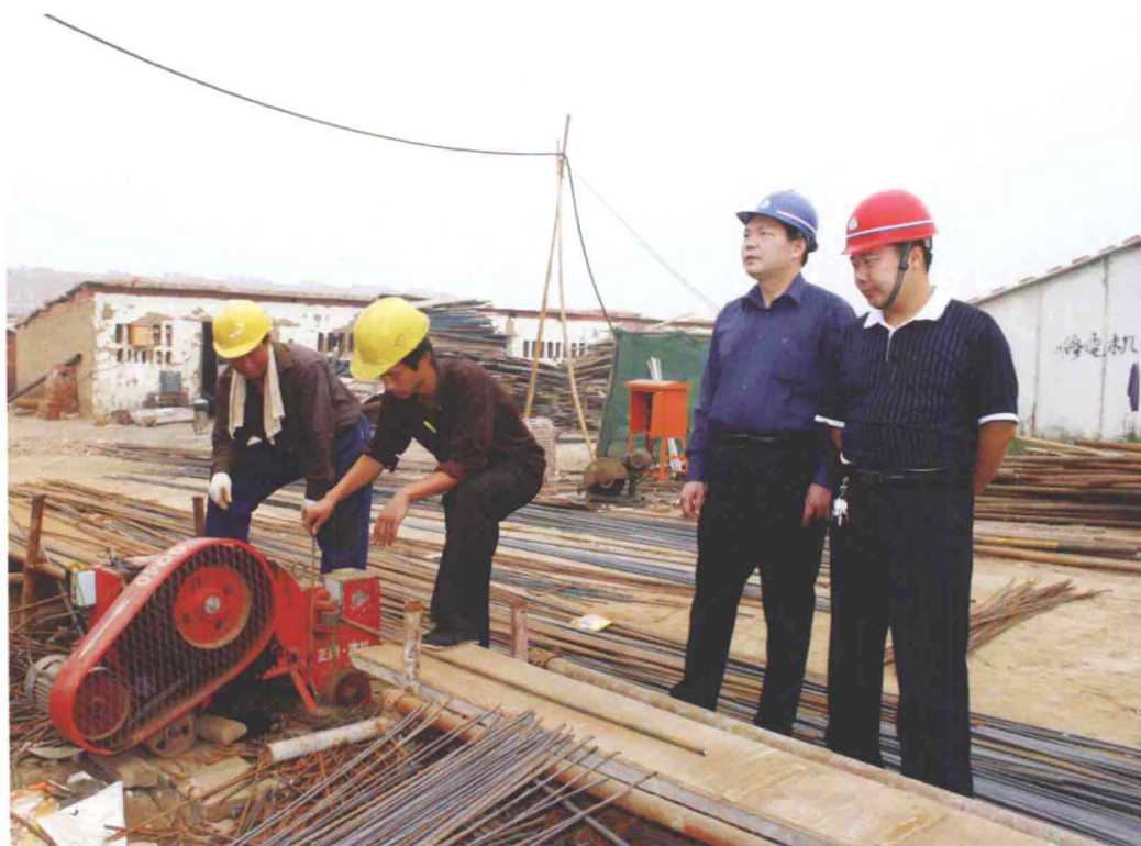
区东区工委书记助理王德同在南安置区施工现场
