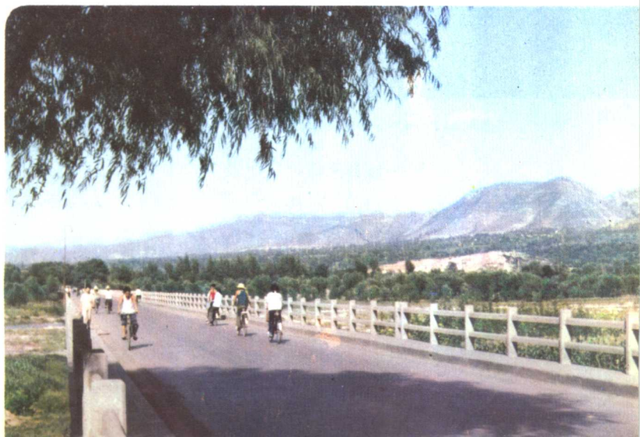
城南清漳河公路大桥
