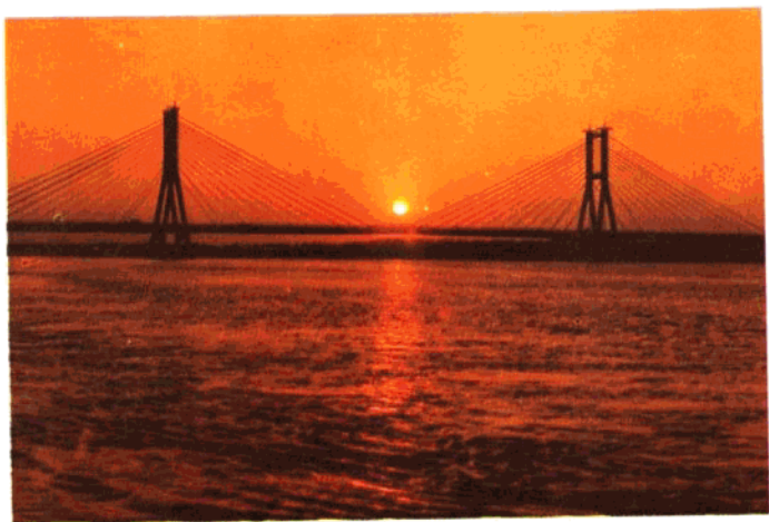
黄河公路大桥
