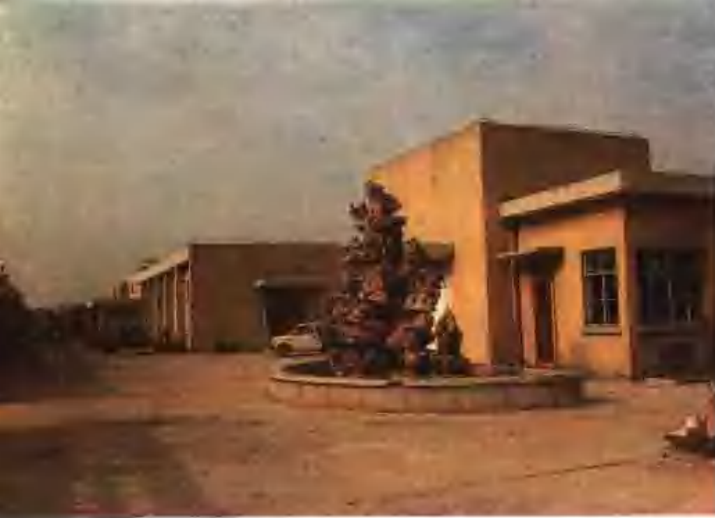
金山水厂一级泵站
