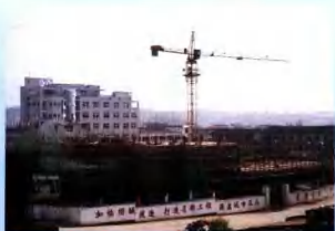
锦华工厂 锦田镇改造施工现场
