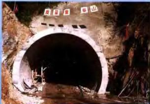
环费山公路宏村至儒村段隧道工程施工现场
