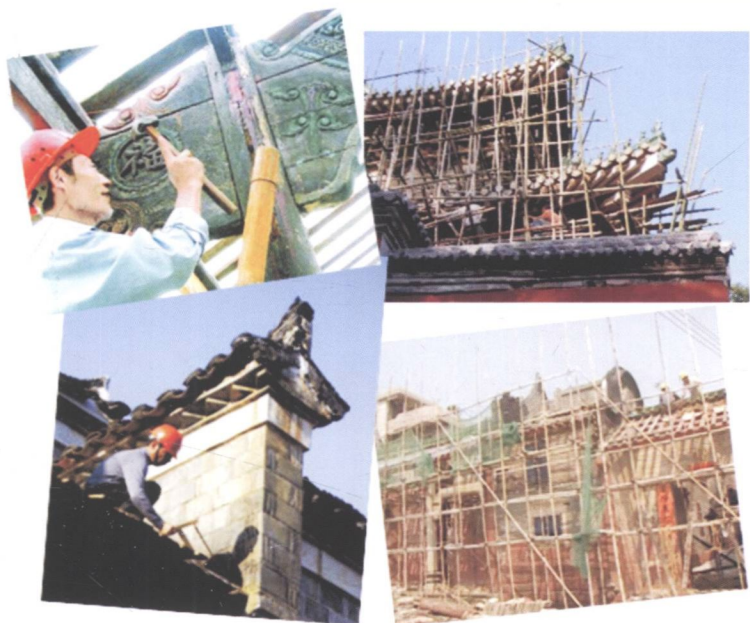
横沥对古建筑进行维修保养
