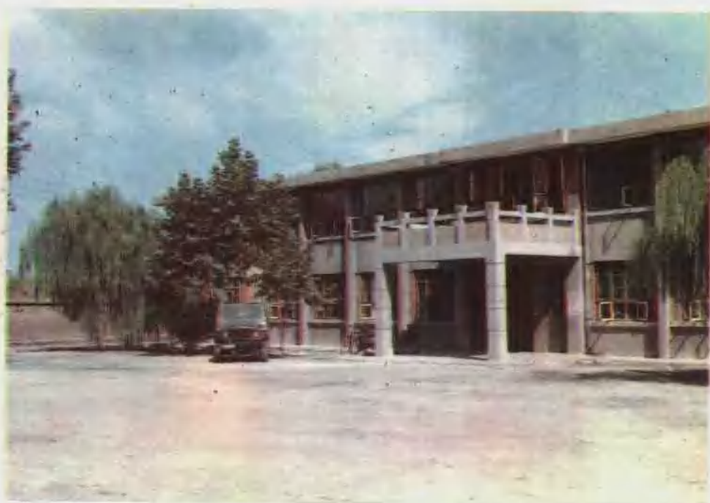
职工医院门诊楼
