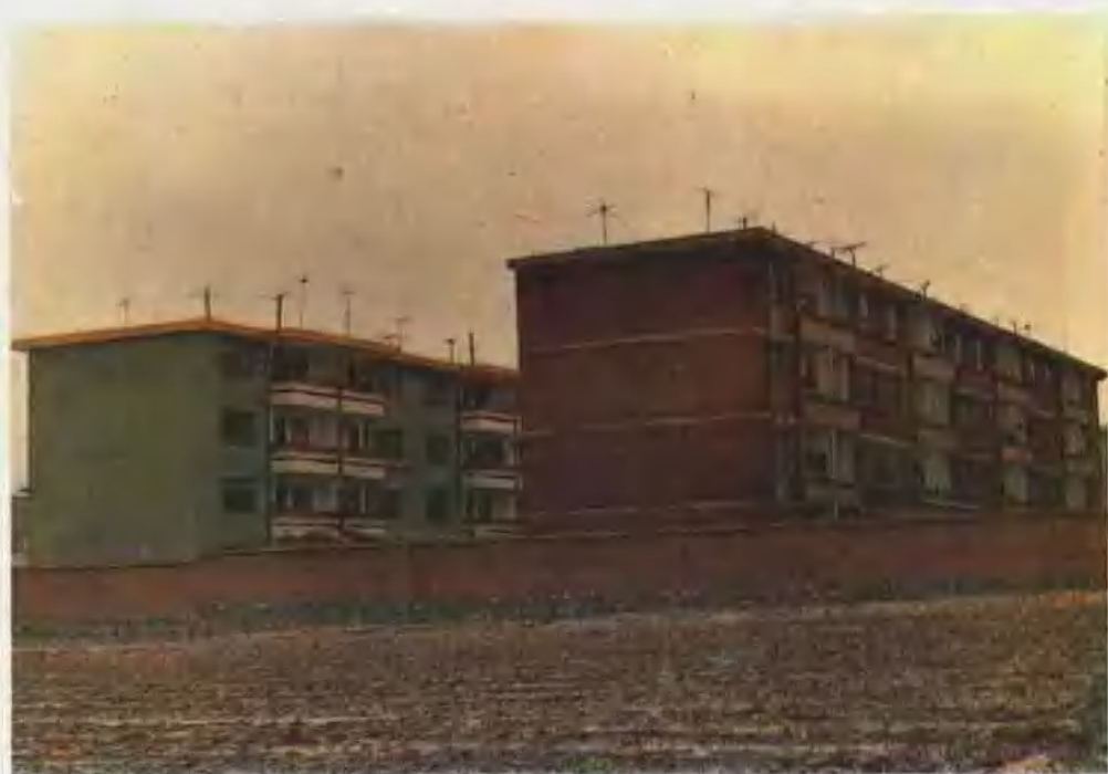
新建工程师宿舍楼
