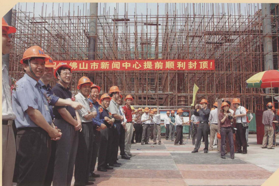
▲ 4月29日，佛山新闻中心提前封顶，预计会在明年6月竣工。这个集多家新闻单位于一体的大型建筑群，建成后将成为国内第一个跨媒体的集团中心。
