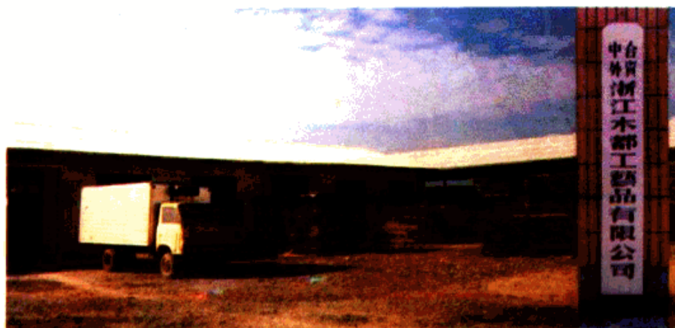
木都公司生产工场
