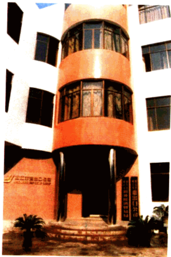
椒江市对外经济 济贸易局、椒江市 进出口公司新建的 办公大楼。
