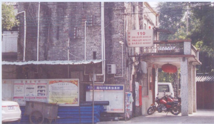
尧均炮台侧面2
