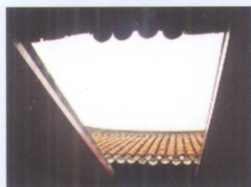
公祠天井及屋梁
