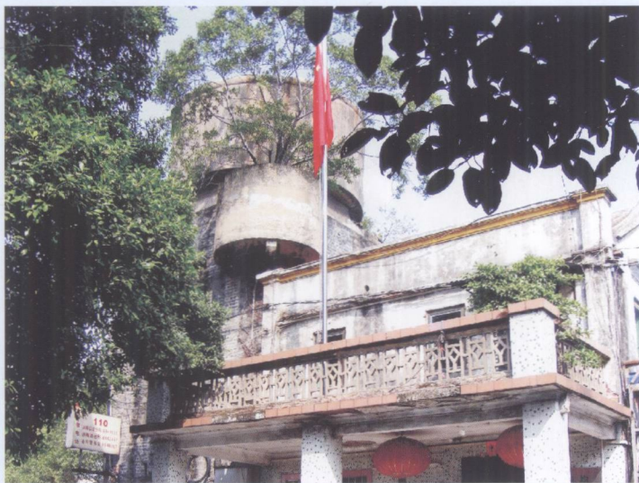
尧均炮台侧面1
