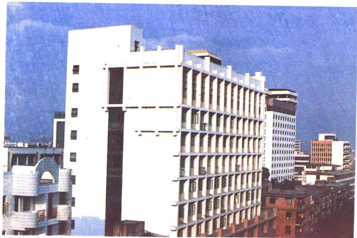
位于福州市区中心的福建省财会管理干部学院综合大楼。
