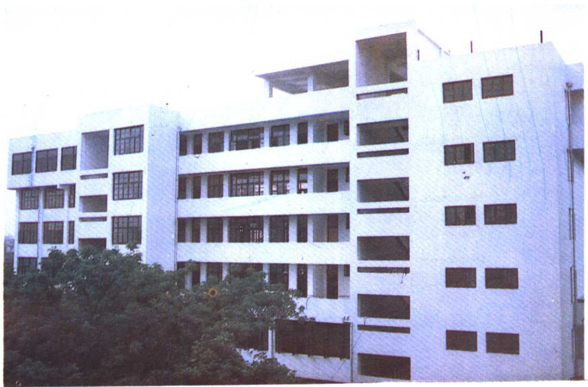
漳州教育学院教学综合大楼。
