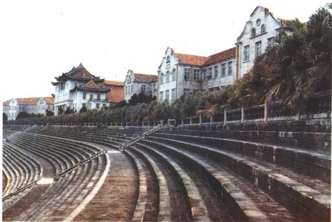
厦门大学建南大礼堂建筑群丰姿。
