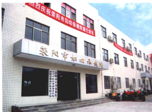
市妇幼保健院新址门诊大楼
