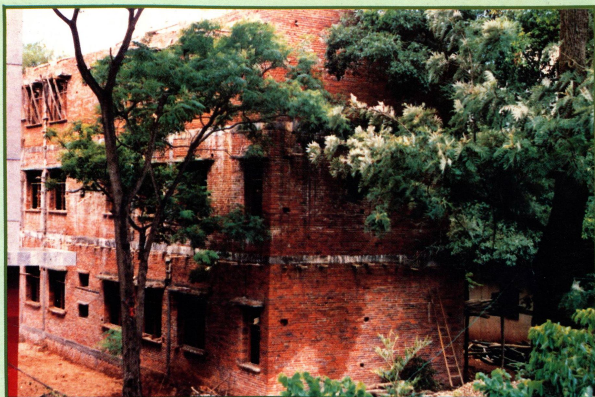
正在興建的教學樓
