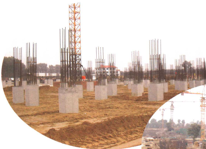
建设中的良乡校区。
