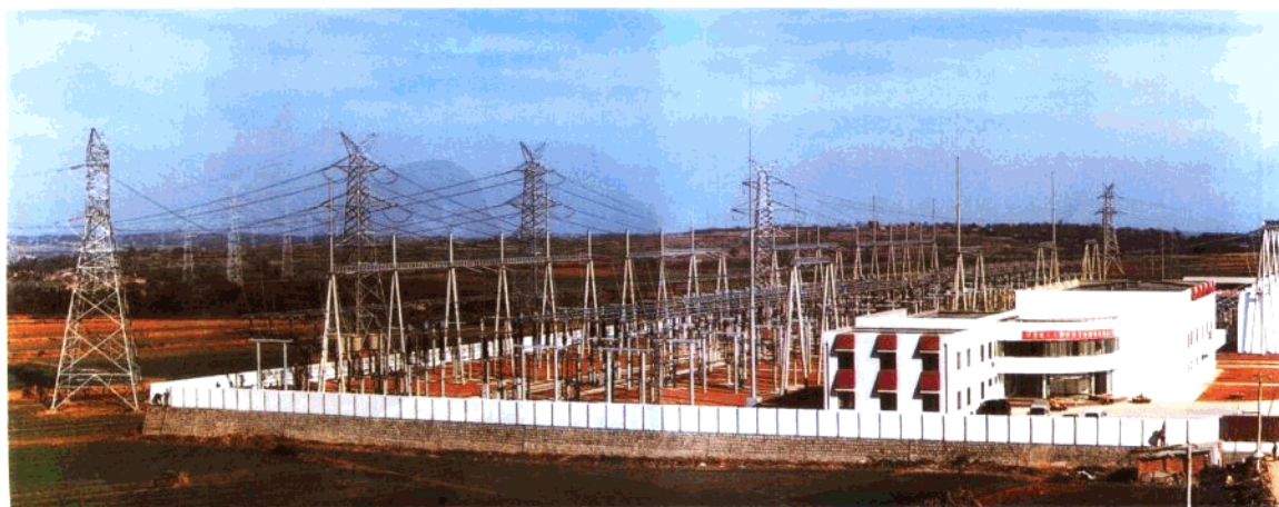
承建500kV洛阳牡丹变电站(1999,国优)
