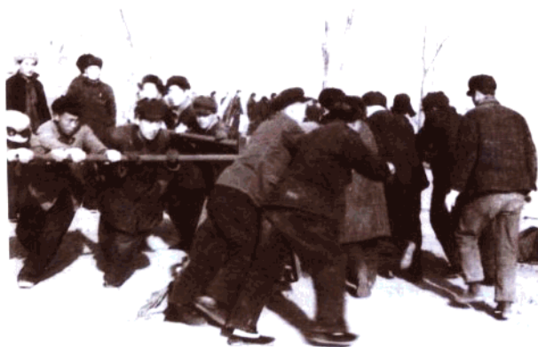
50年代末施工中使用人力绞磨
