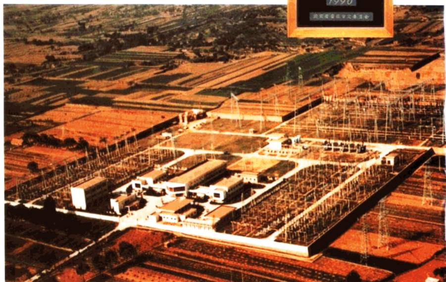
承建河南第一座500kV郑州(小刘)变电站(1988,国优)
