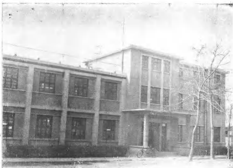
中国工商银行微山县支行办公楼
