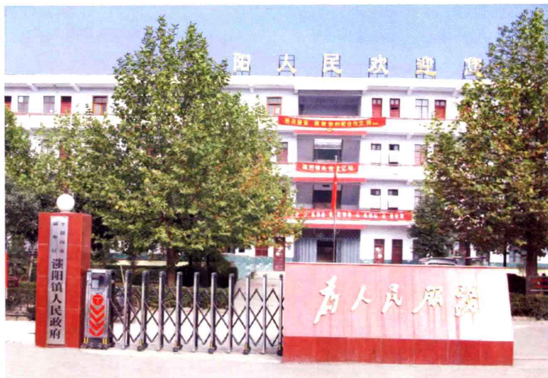
潢阳镇政府办公楼
