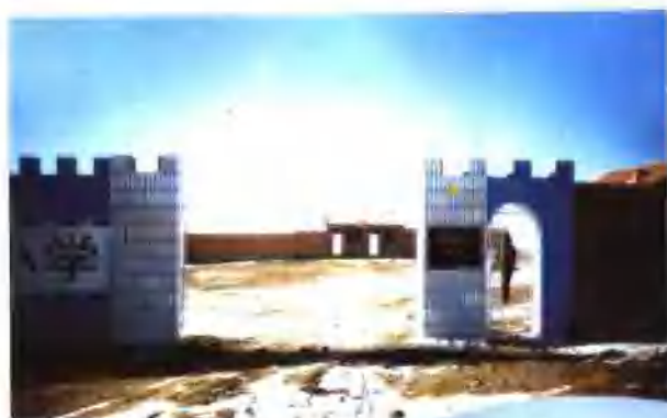
八道沟镇东水小学 (1998年建)
