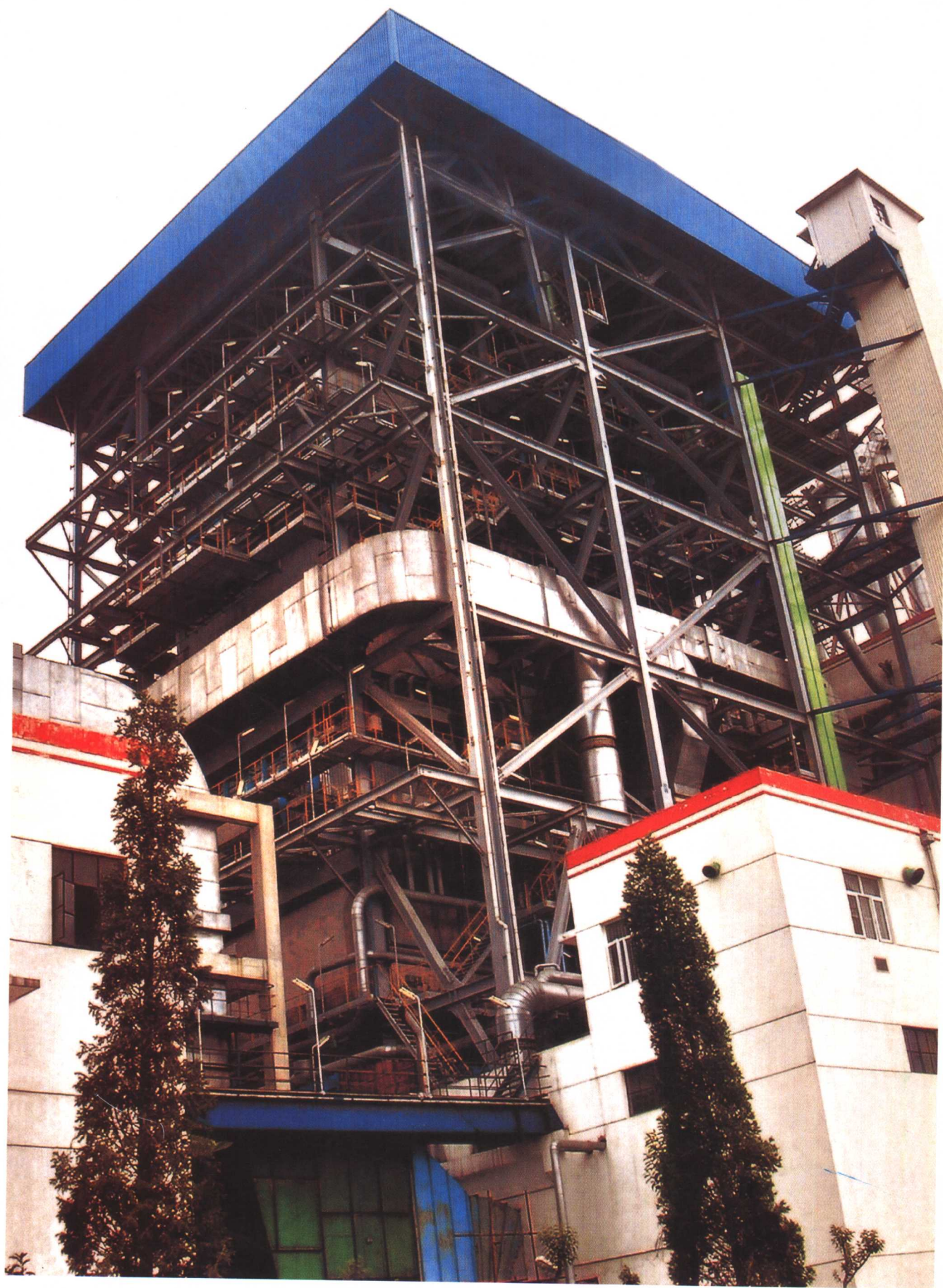
▲扬子石化热电厂增建 410 吨 / 时锅炉
