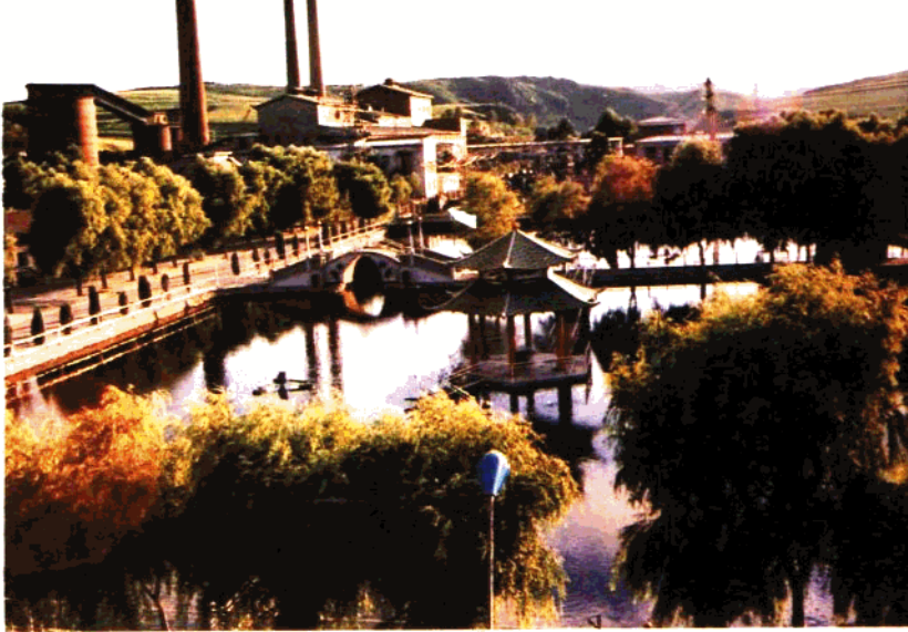
► 东宁发电厂一角
